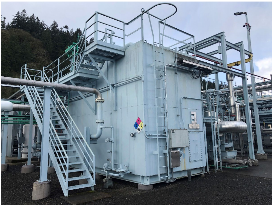
Figure 6.24: Portland LNG Cold Box
